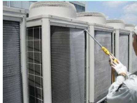
室外機高圧洗浄
