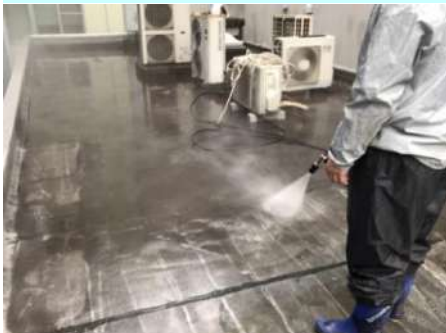
屋根高圧洗浄
