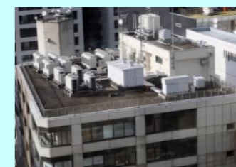
室外機遮熱・断熱コート
