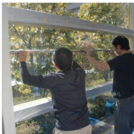
スポンジバー工法
