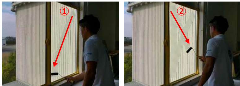
2) 対角線状(エックス)にローラーを転がす
